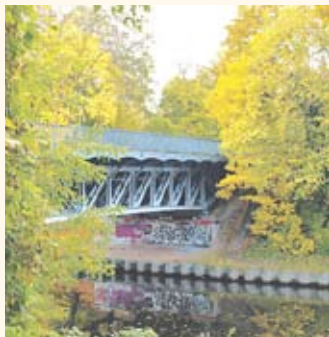
Bäkebrücke in Lichterfelde.
